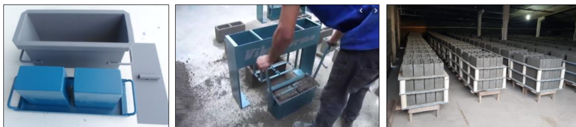
Figura 11: Confeção dos blocos de concreto: (a) forma; (b) adensamento e conformação dos blocos; (c) cura dos blocos.
