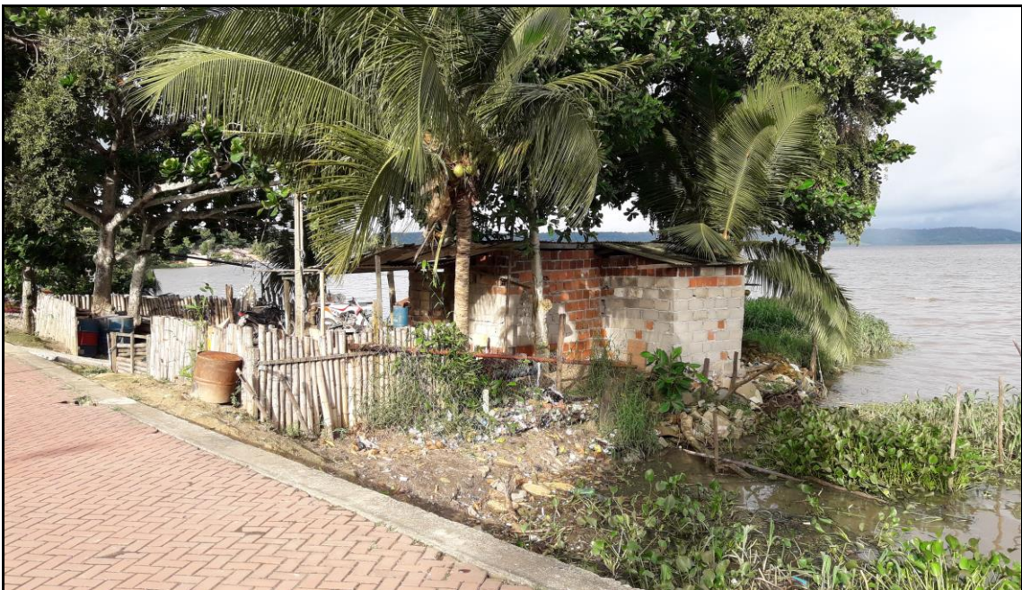
Figura 21 - Construção irregular sobre a laguna Manguaba.
