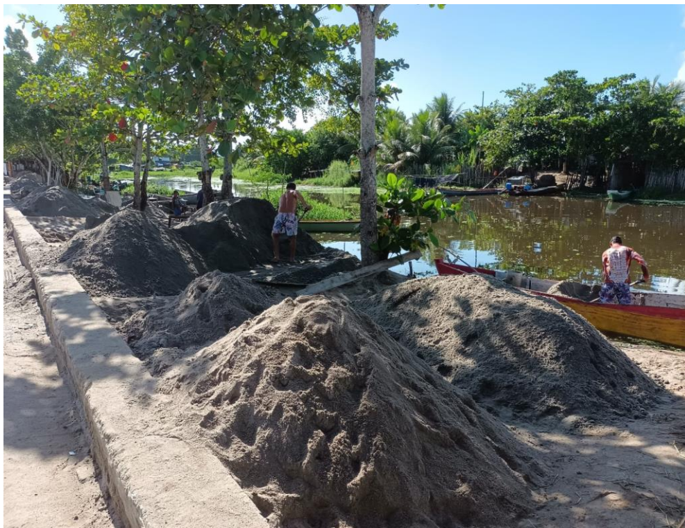
Figura 23 – Trabalhadores na remoção de areia retirada do leito do rio Paraíba do Meio.
