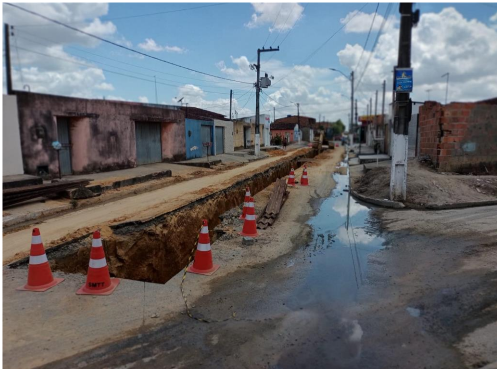
Figura 12- Obra de saneamento na Rua Dr. Antônio Serafim Costa, na Chã do Pilar.
