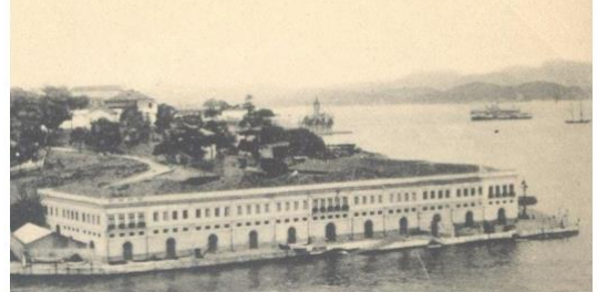
Figura 11 -Fortificação da Ilha das Cobras
