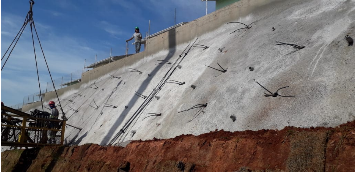
Figura 14 - execução da tecnica solo grampeado.
