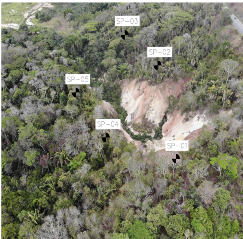
Figura 31: Vista do posicionamento das novas sondagens.
