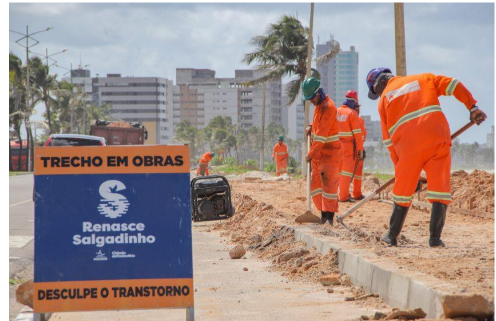
Figura 19. Início das obras do Programa Renasce Salgadinho
