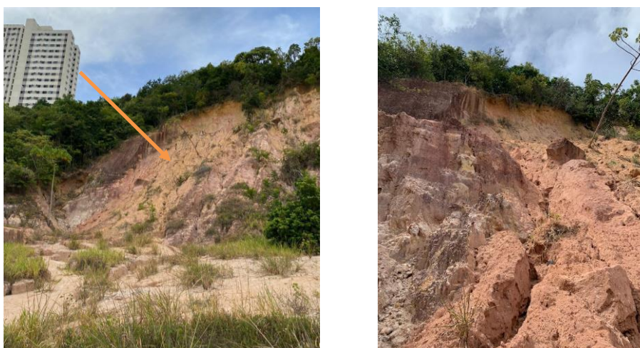
Figura 52 - Evidências de movimento circular ou rotacional
