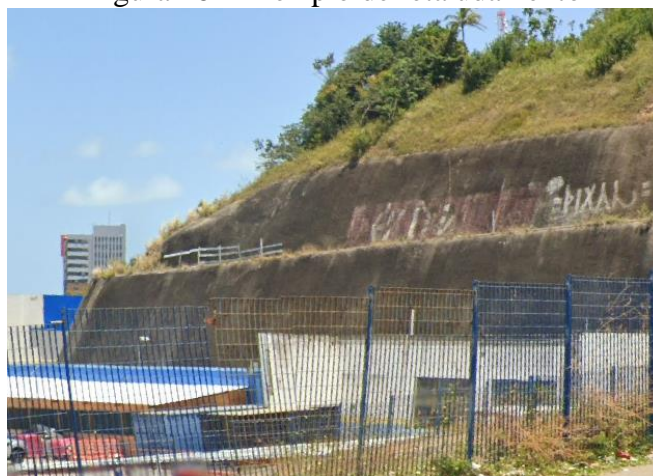
Figura 16 - Exemplo de retaludamento
