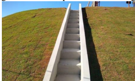
Figura 18 - Exemplo de escada d'água
