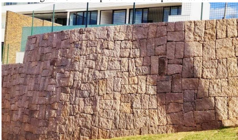
Figura 28 - Exemplo de muro de pedra rachão
