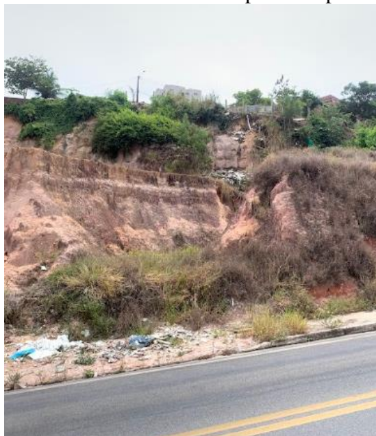
Figura 50 - Evidência de lixo depositado pelo talude
