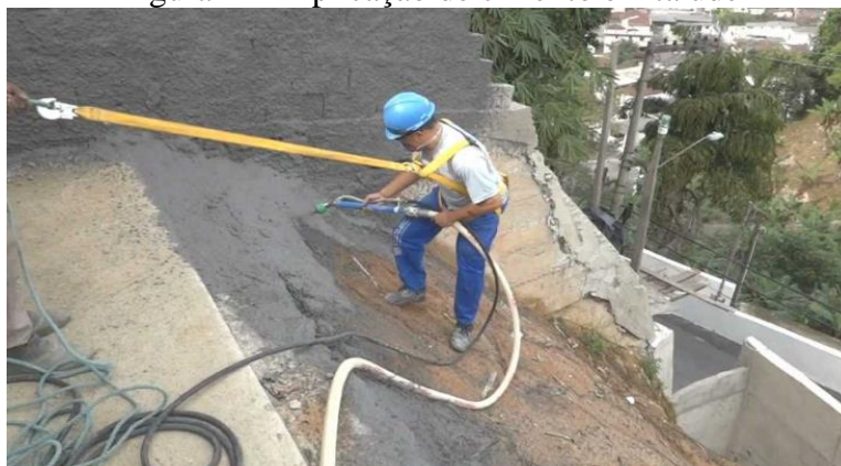
Figura 24 - Aplicação de cimento em talude
