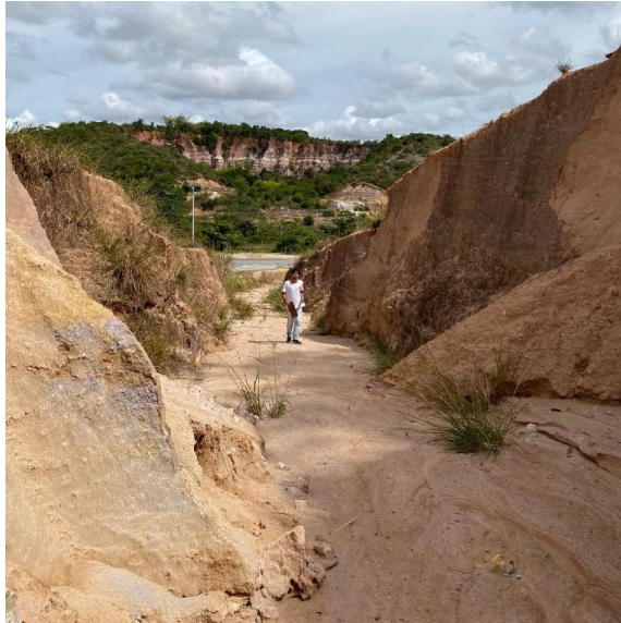
Figura 55 - Evidência de deslizamento de grande porte
