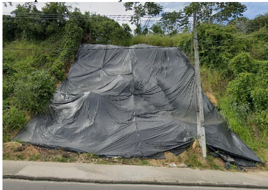
Figura 26 - Impermeabilização de talude com lonas plásticas
