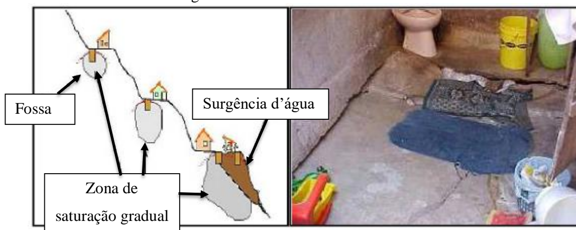
Figura 12- Vazamento de fossa sanitária
