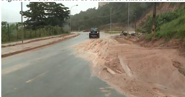
Figura 35 - Movimentos de terra na Avenida Pierre Chalita
