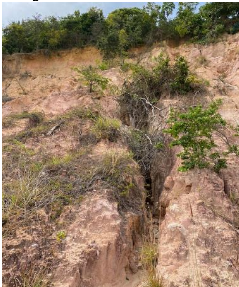
Figura 53 - Evidência de ravinas
