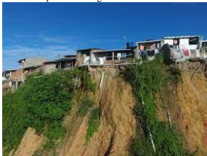
Figura 10 - Lançamento de águas servidas na Favela do Bolão
