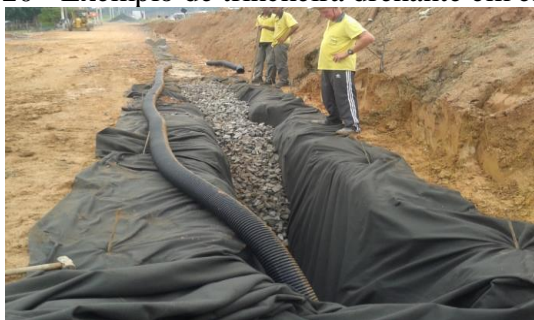
Figura 20 - Exemplo de trincheira drenante em execução
