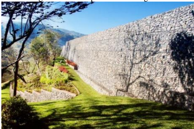
Figura 29 - Exemplo de muro de gabião
