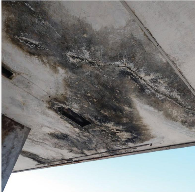
**Figura 35** - Infiltração em estado avançado na laje do 11º andar.
