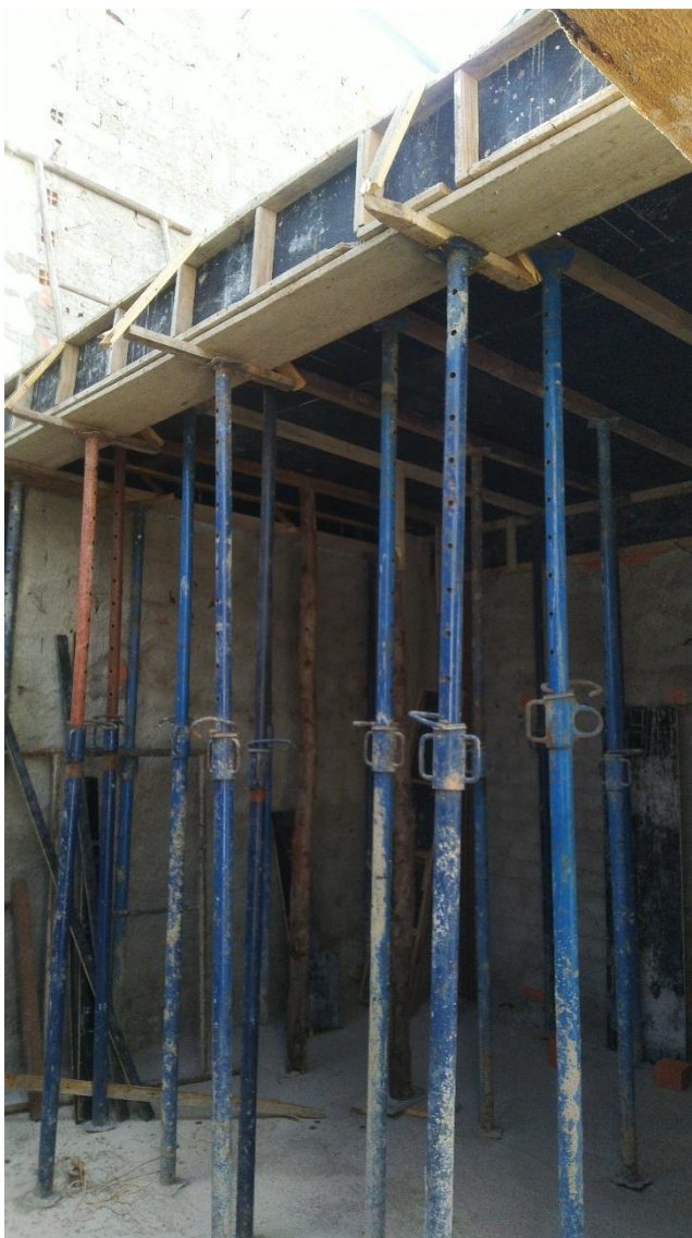
Figura 4 - Escoramento de fôrmas metálico e de madeira
