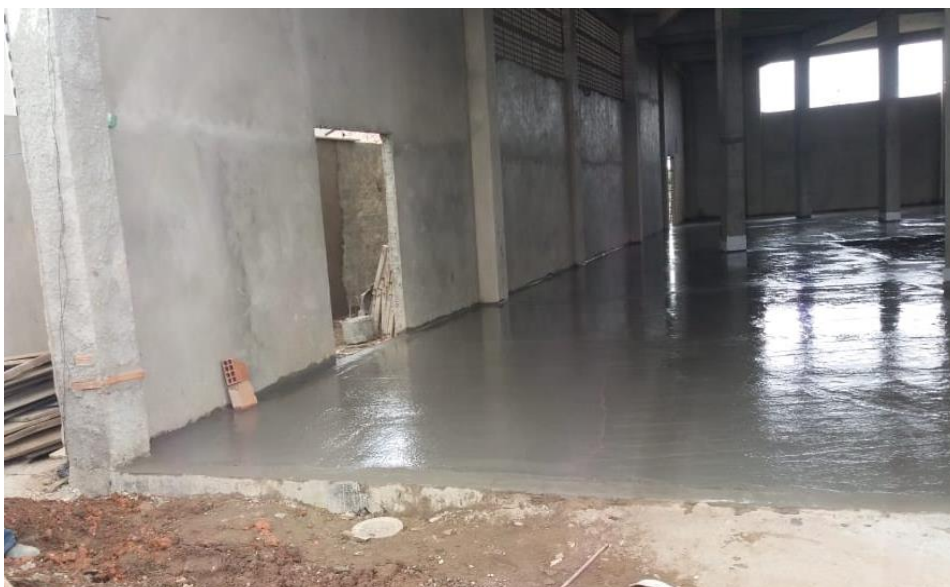
Figura 40 - Imagem resgatada do momento da execução do piso - Edificação 3
