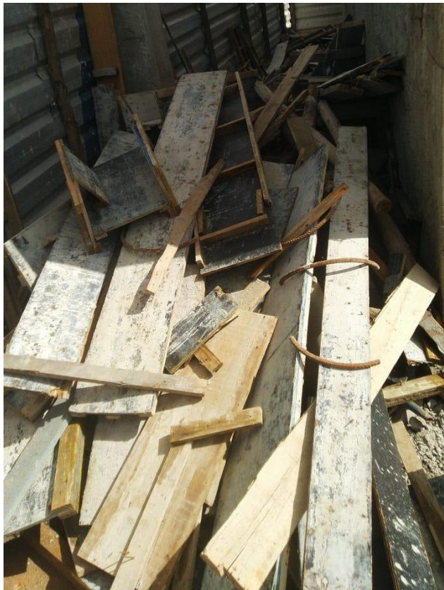
Figura 3 - Madeira utilizada nas fôrmas
