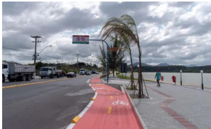
Figura 44 - Pintura na via demarcado funções
