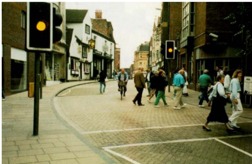
Figura 40 - Plataforma utilizada em travessia de pedestres
