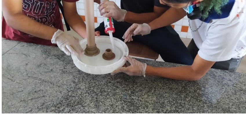
Imagem 12: Montagem e vedação do alimentador e da saída de gás da câmara de digestão.
