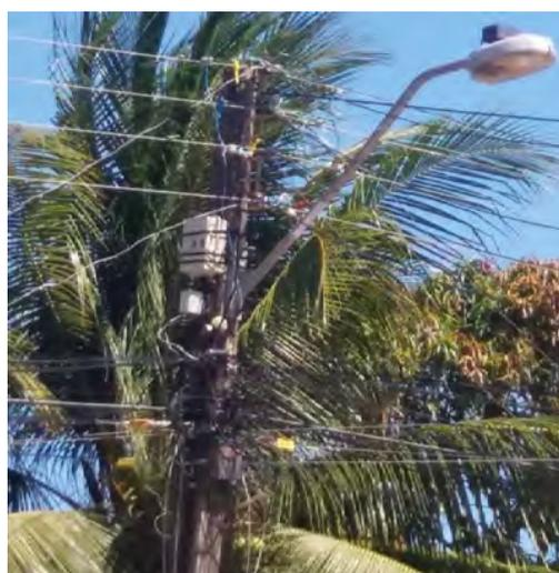
FIGURA 09 – Instalação do analisador de energia no poste 07, aonde está instalado o 4 relé de telegestão da iluminação pública, no qual foi aplicada a métrica.
