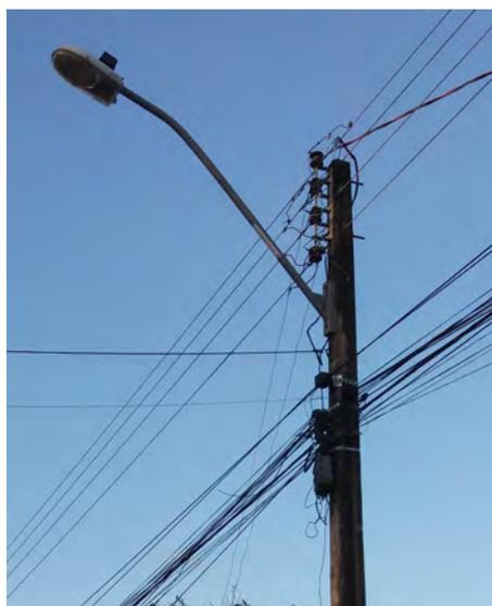
Figura 17: Foto com detalhe da ligação dos cabos da luminária na rede de distribuição e identificação do estudo no braço da luminária. Fonte: Elaborado pelo autor.
