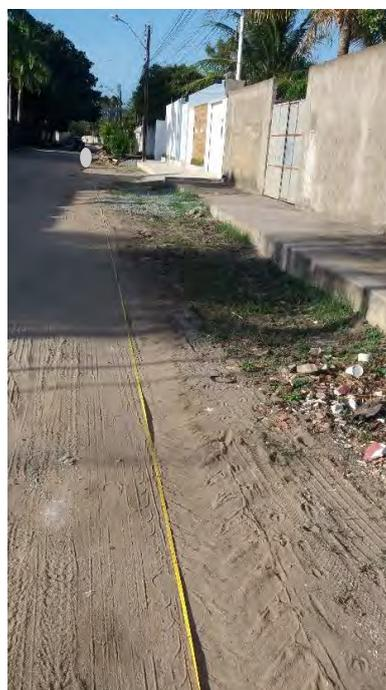
FIGURA 13 – Medição realizada por trena com objetivo de verificar a distância entre os pontos de iluminação do estudo.
