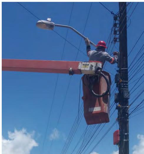
Figura 16: Foto do Padrão I2 do modelo das luminárias que foram instaladas e um dos protótipos dos relés desenvolvidos por este autor instalado acima da luminária. Fonte: Elaborado pelo autor.
