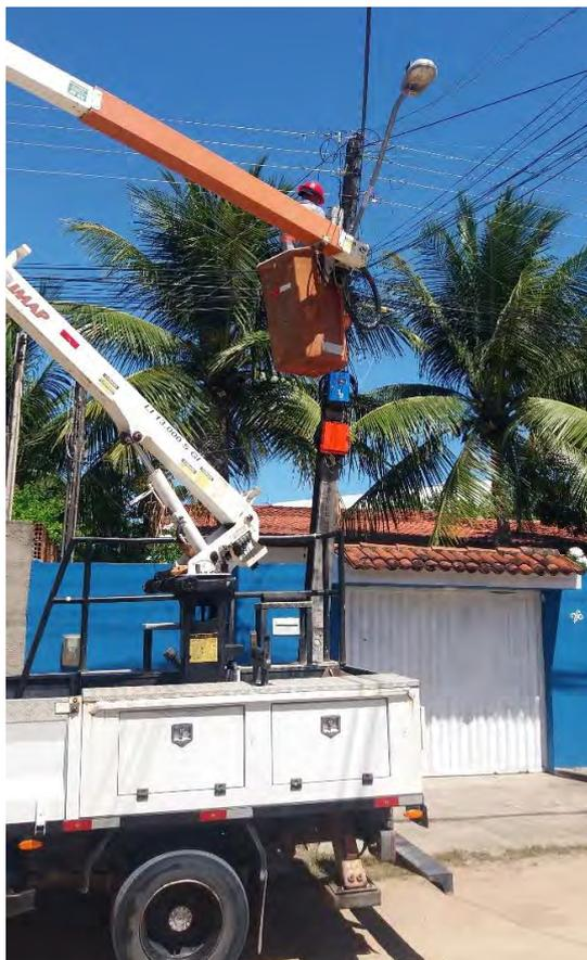
FIGURA 07 – Substituição da quarta luminária na rede de distribuição ligada a fase A e instalação do analisador de energia modelo PowerNET P-600 G4 do fabricante IMS, conforme proposta do estudo.
