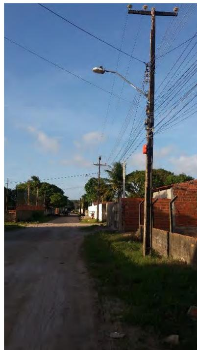
FIGURA 11 – Imagem do segundo ponto de iluminação ligado a fase B e o próximo ponto de iluminação ligado a fase C.
