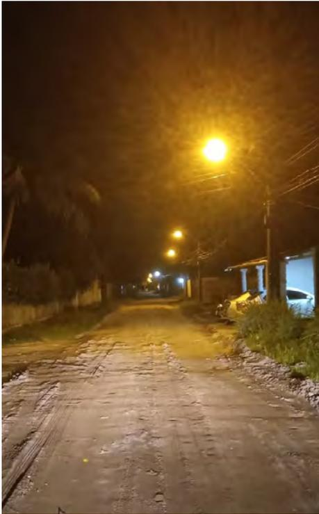
FIGURA 14 – Imagem dos três primeiros pontos de iluminação com lâmpadas do tipo vapor de sódio, ligado respectivamente nas fases A, B e C e ao fundo é possível identificar os últimos três pontos de iluminação.
