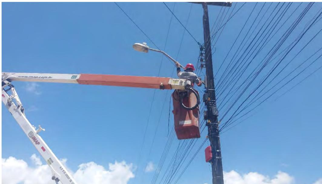
FIGURA 05 – Substituição das luminárias na rede de distribuição conforme proposta do estudo. Imagem do segundo ponto de iluminação ligado a fase B.
