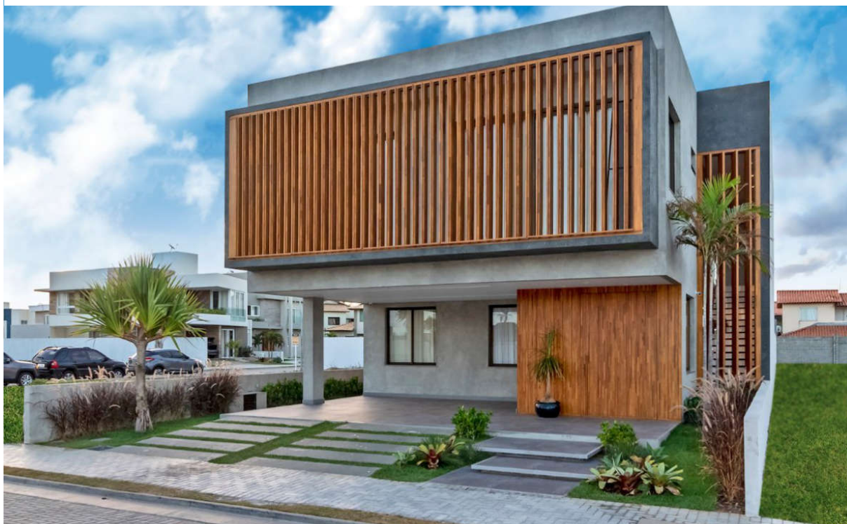
Figura 12 - Fachadas protegidas por películas e brises
