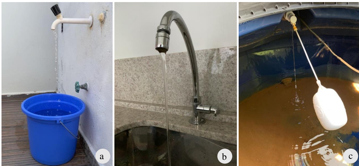
(a) Torneira do jardim; (b) torneira da pia da cozinha; (c) Cisterna enterrada com vazão igual a 0,01L/s.
