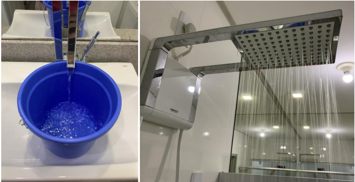
Figura 24 - Medições realizadas nos pontos de uso de água
