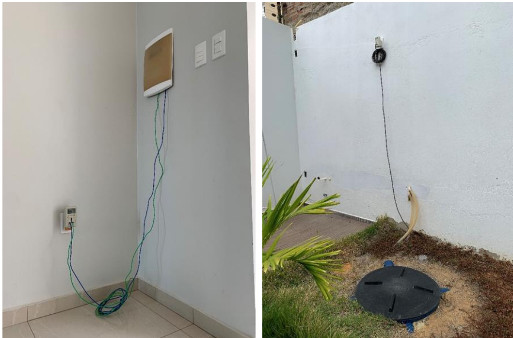
Figura 27 - Medição de consumo adaptada (condicionar de ar e bomba submersa)
