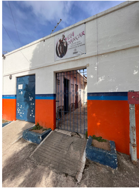
Figura 18: Entrada do Centro Comunitário das Piabas, localizado na Rua Maria Cecília da Rocha, no Jacintinho
