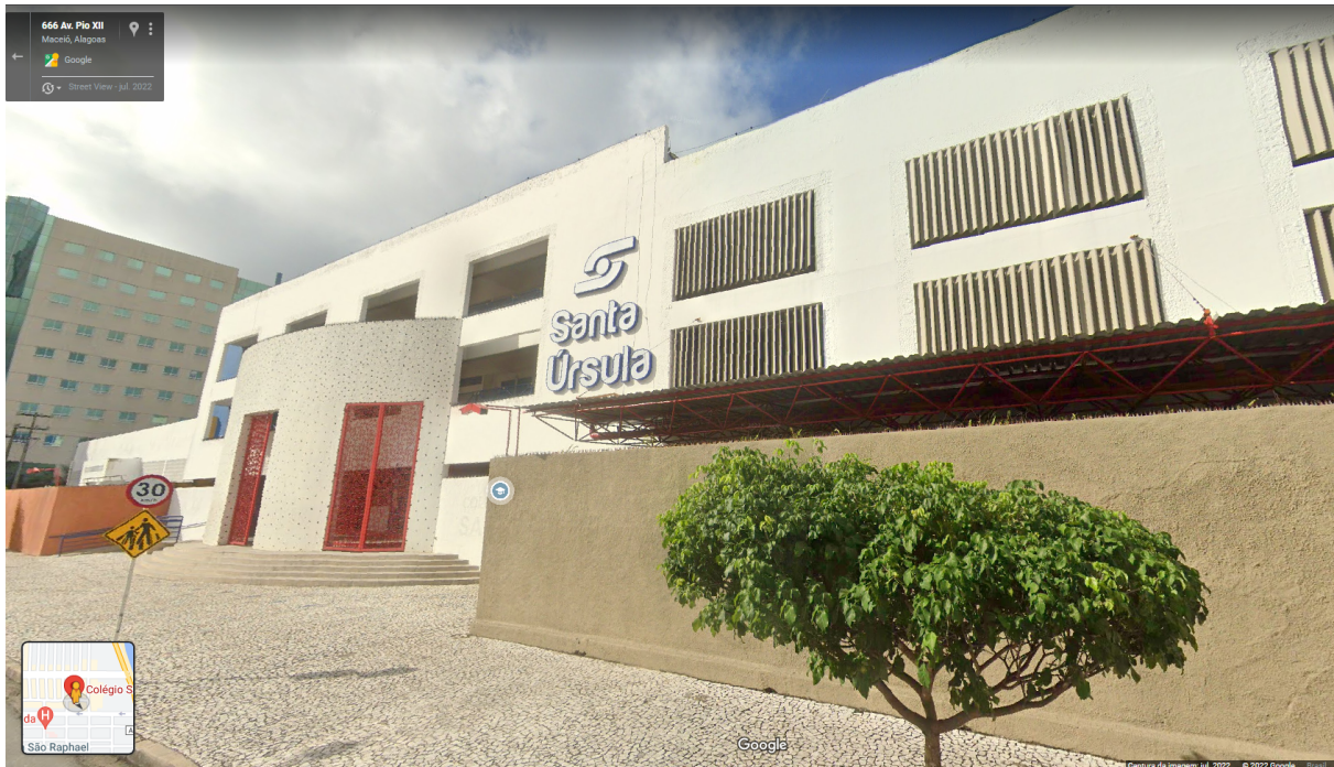
Figura 37: Telha metálica sobre estrutura de treliça espacial no Colégio Santa Úrsula, em Maceió-AL.
