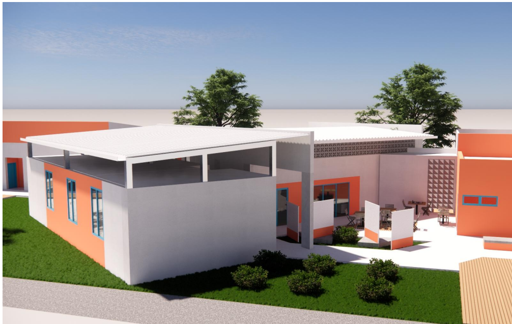
Figura 65: Perspectiva do Bloco 02, é possível visualizar a separação entre a coberta e os ambientes, tanto na biblioteca como nas salas .
