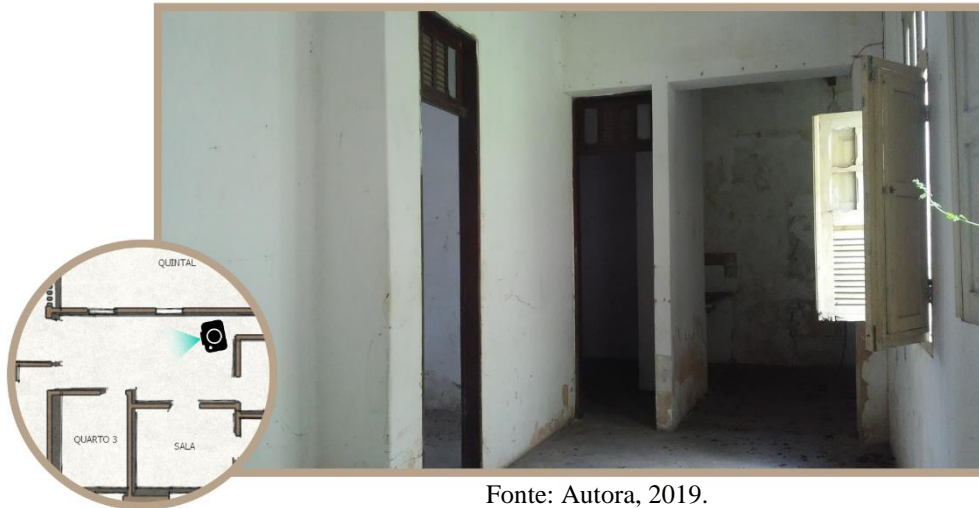
Figura 87- Sala de jantar da residência.
