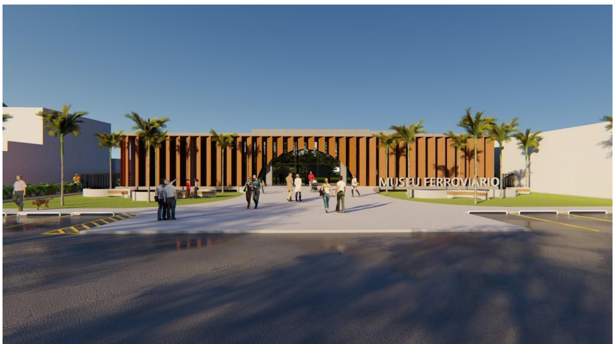
Figura 116- Brises verticais da fachada de acesso ao museu.
