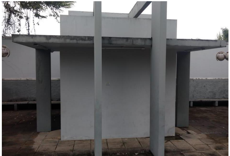
Figura 70- Edificação dos banheiros feminino e masculino para o público.
