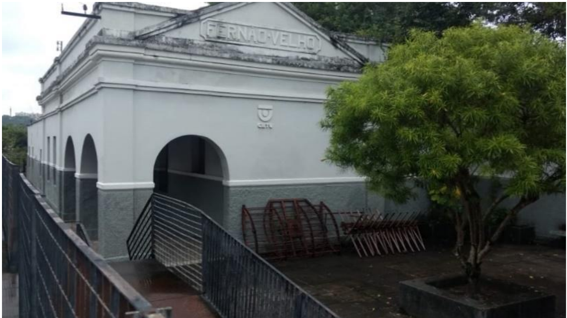
Figura 68- Edificação subutilizada da Estação Fernão Velho.
