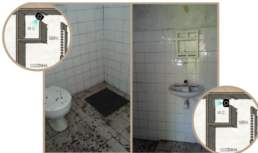
Figura 88- W.C da residência.
