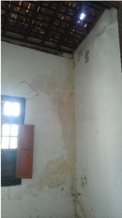
Figura 69- Problemas de infiltração e no telhado.
