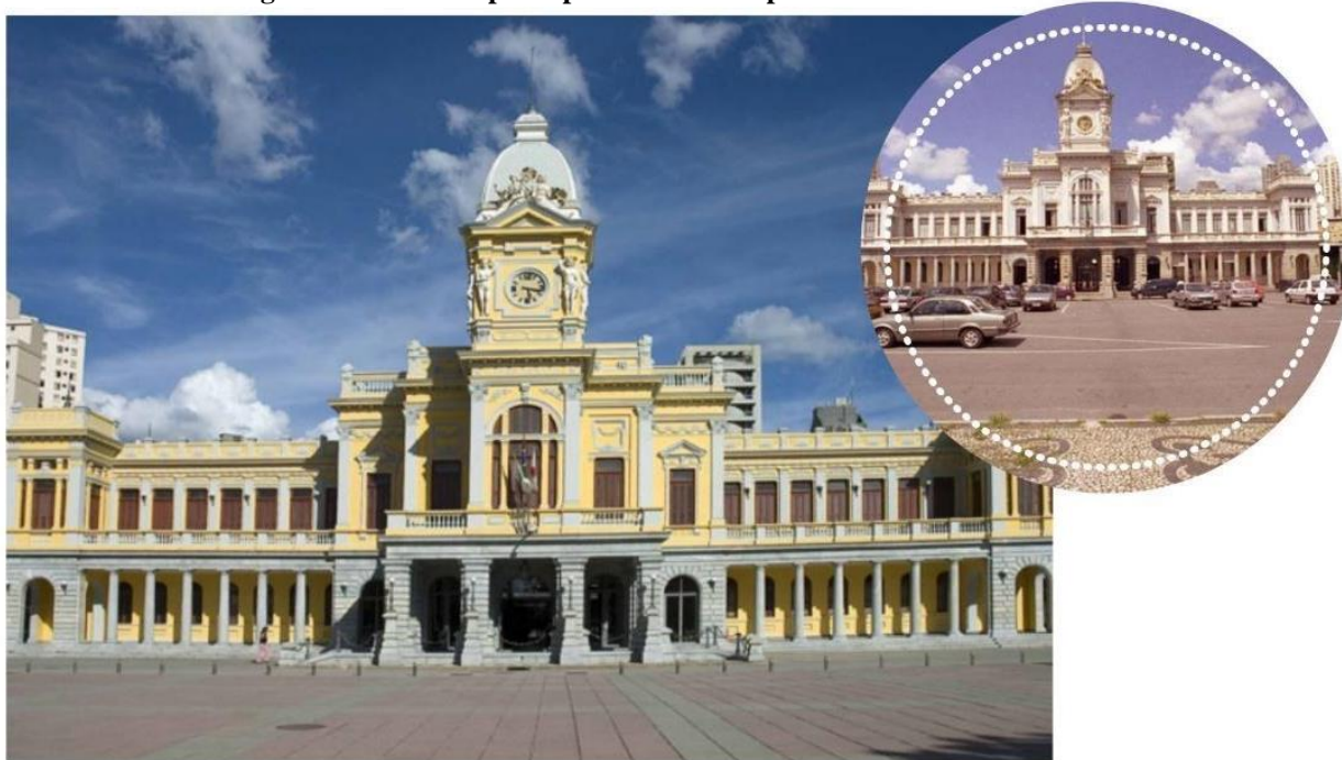
Figura 36- Fachada principal – Antes x Depois.
