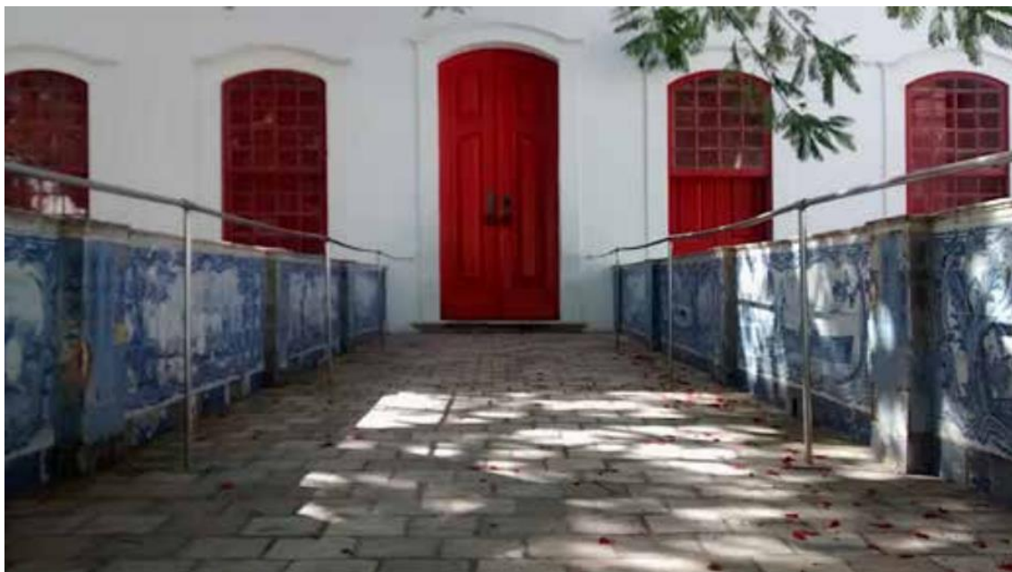
Figura 16- Azulejos restaurados no acesso ao casarão. Museu de Arte Moderna da Bahia, Salvador, BA, 2015.
