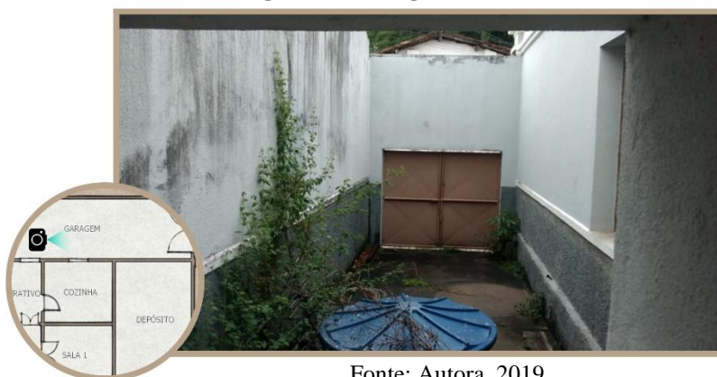
Figura 99- Garagem do administrativo.
