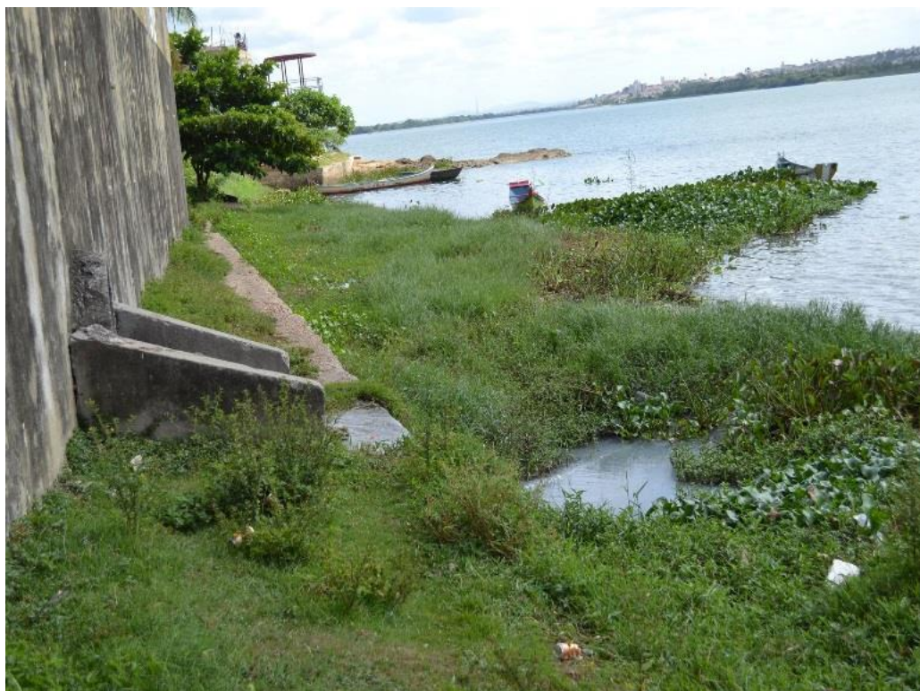
Figura 4 - Despejo de esgoto domiciliar no Rio São Francisco, trecho que margeia Neópolis/SE.
