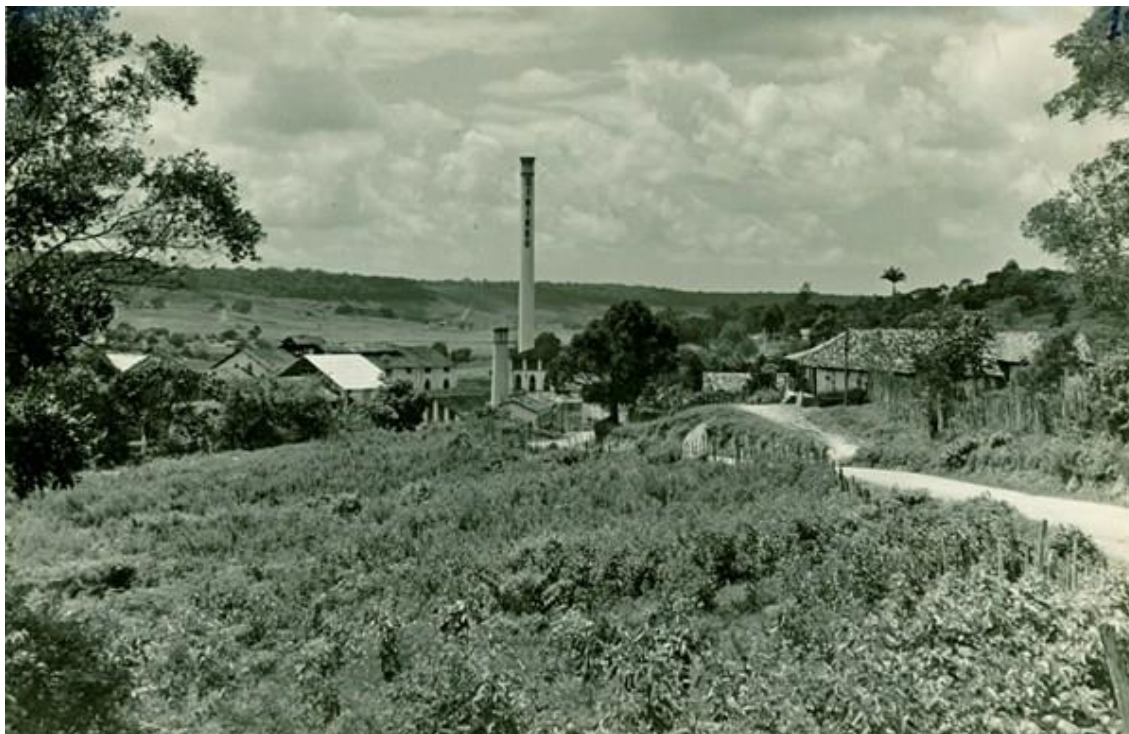
Figura 42 – Vista parcial da Usina Sinimbú.
