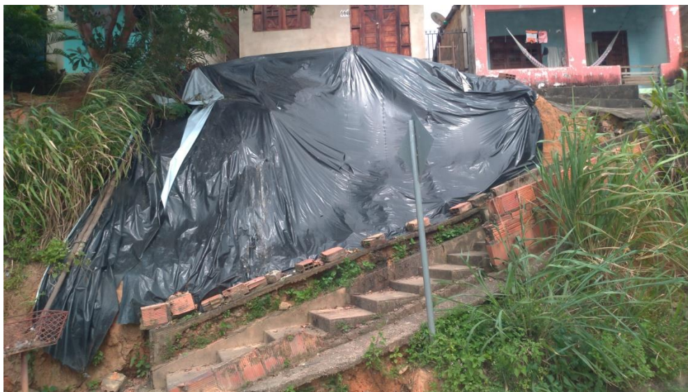
Figura 72 – Construção nas encostas.
