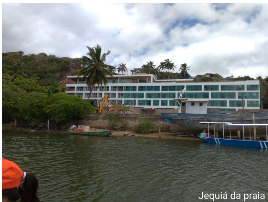
Figura 45 – Hotel em construção em Duas Barras.
