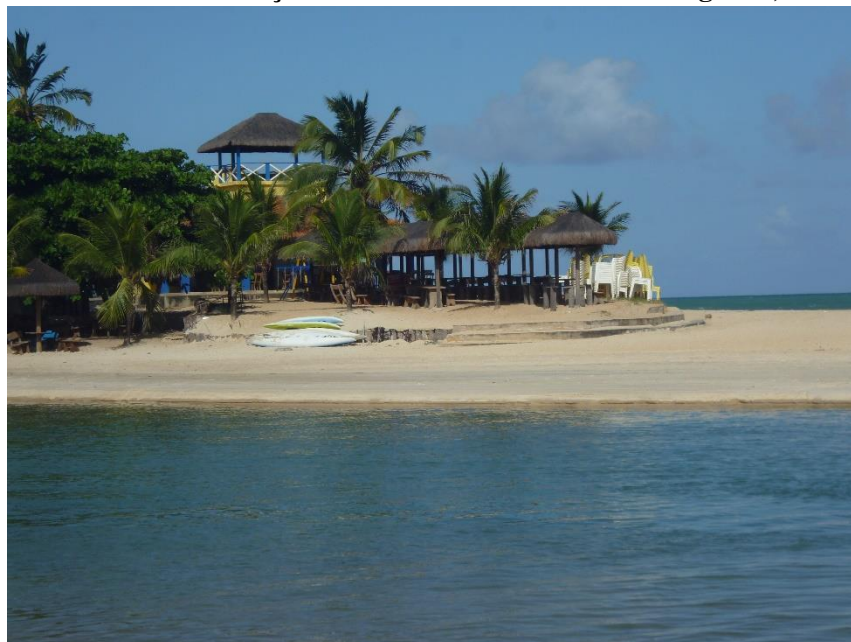
Figura 73 – Muro de contenção na desembocadura do canal lagunar, em Duas Barras.
