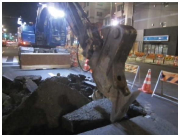
Figura 6: Reparação da superfície da estrada. Fonte: [Bureau 2015]
