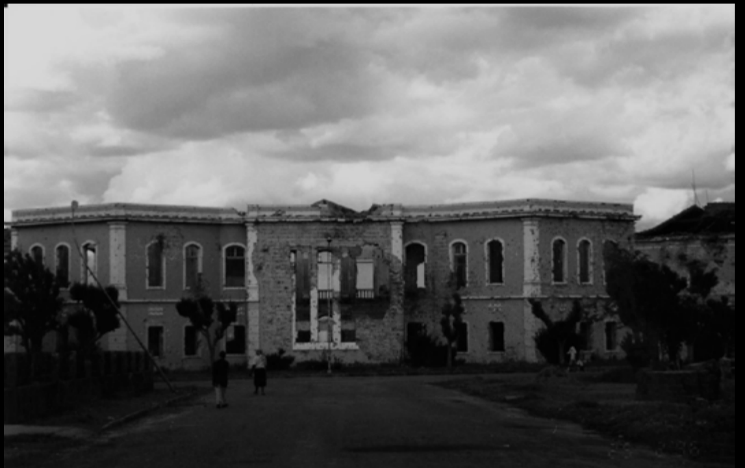
Prédio do seminário
