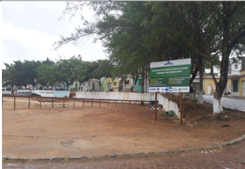
Figura 42 - Obras da USB iniciadas na Praça Francisco Cavalcante.
