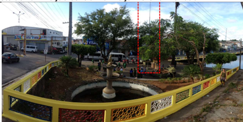
Figura 24 - Poste de iluminação central na Praça Moreno Brandão
