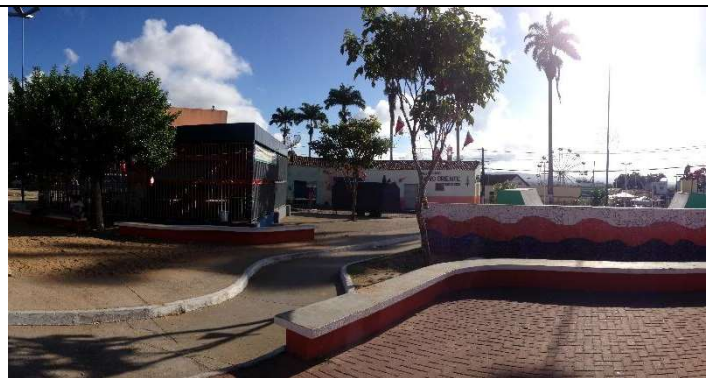
Figura 20 - Bancos de alvenaria na Praça do Skate
