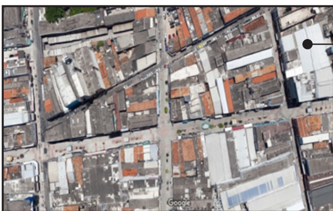
Figura 5 - Tipologia do bairro Centro histórico de Maceió Fonte: Google Maps (2019)
