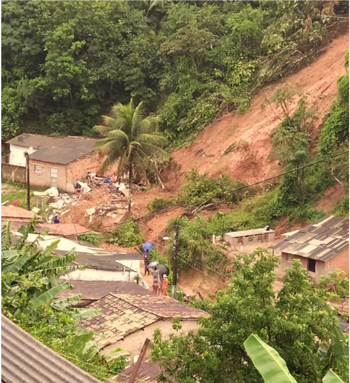
Figura 32 - Desmoronamento na Grota de Santa Helena, Chã de Bebedouro Fonte: Edilson Omena, 2021
