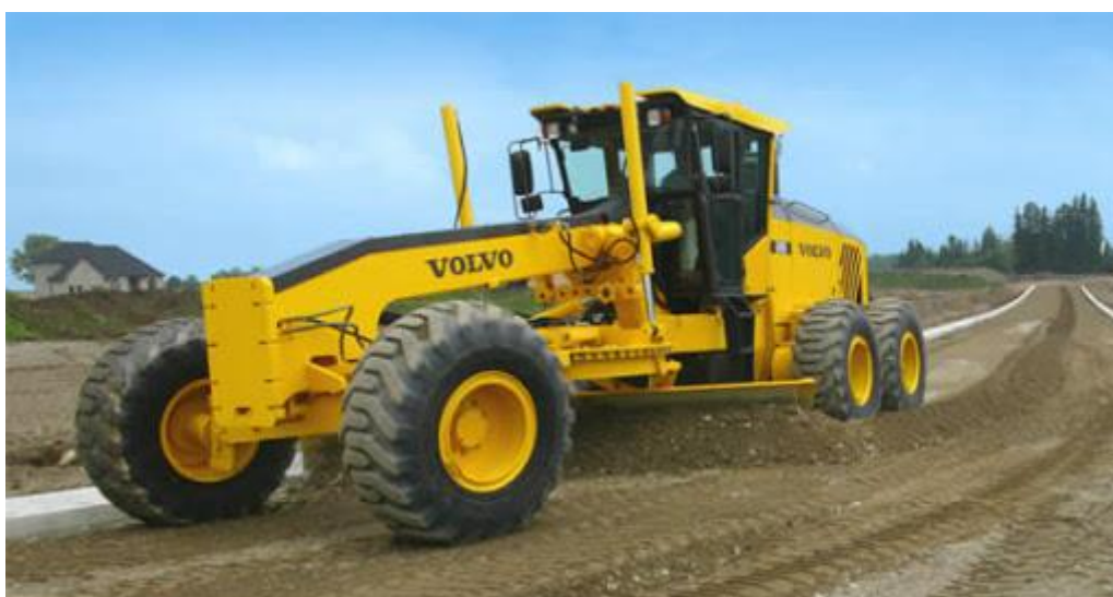
Figura 20. Atividade de nivelamento
