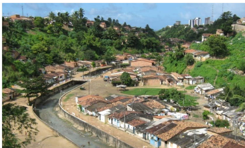
Figura 20 – Vista panorâmica do Vale do Reginaldo, município de Maceió, Estado de Alagoas, 2008.
