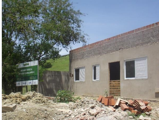
IMAGEM 39 – Posto de Saúde em construção de Sabalangá.
