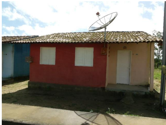
IMAGEM 8 – Casa de alvenaria.
