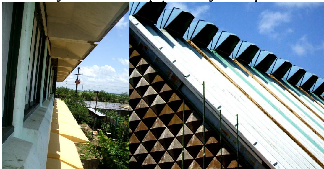
Figura 27- Elementos de captação de ar no ginásio de esportes.
