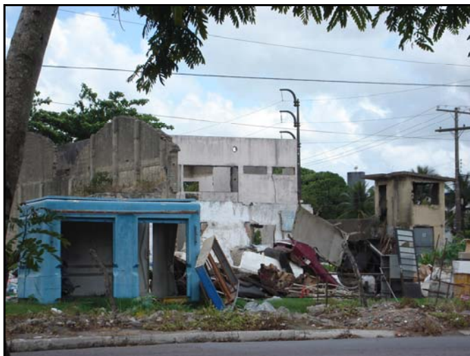
Figura 20 – Edifício em processo de degradação.
