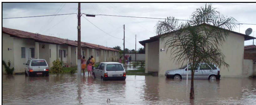
Figura 53 – Alagamento no condomínio Residencial Ernesto Gomes Maranhão.
