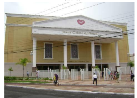
Edificação de grande porte ao lado de um Shopping Center e de avenida de grande circulação. Fonte: acervo pessoal, 2010.
