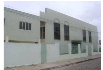
Fachada simplificada e esquadrias contornadas superiormente por arcos plenos. Fonte: acervo pessoal, 2010.
