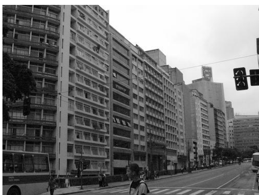
Figura 14 – Rua Xavier de Toledo, SP. Fonte: RUA XAVIER, 2009.
