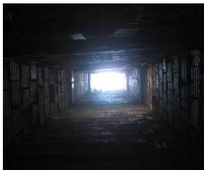
Figura 46 - Vista interna do poço em construção.
