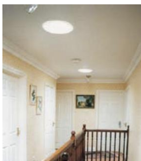
Figura 37 – Iluminação proporcionada pelo duto de Luz no interior de um ambiente. Fonte: PHILLIPS, 2004.
