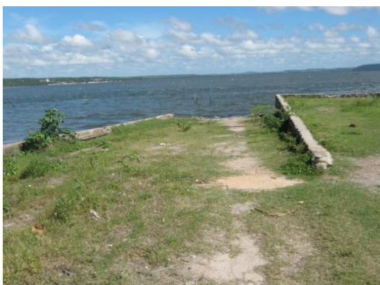
Fig. 19 - Restos da rampa do ancoradouro. Fonte: Arquivo prof. Antônio- Facchinetti. 10/04/2010.
