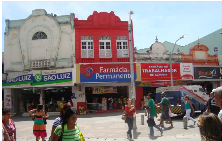
Fig. 22- Centro - Edificações preservadas. Fonte: Arquivo pessoal.
