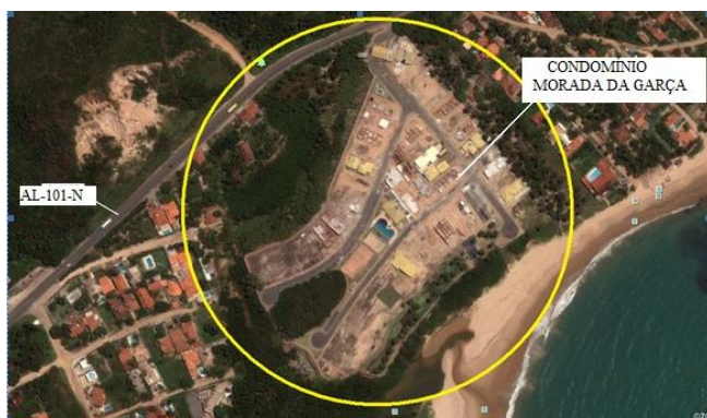
Fig. 106 - Condomínio Morada da Garça – Vista aérea Fonte: Google Earth., 13/05/2010
