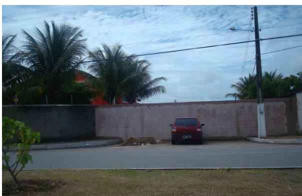
Fig. 127-- Loteamento Recanto da Serraria- Via pública interrompida por muro Fonte: Arquivo pessoal. 14/04/2008
