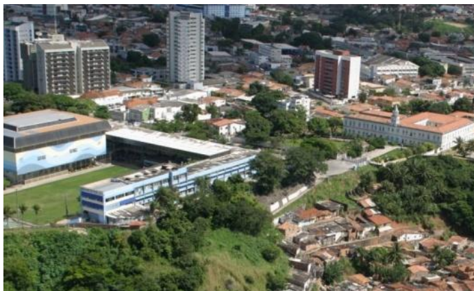
Fig. 47 - Bairro do Farol e ocupações irregulares nas encostas. Fonte: http://www.skyscrapercity.com/showthread.php?t=1117943 .
