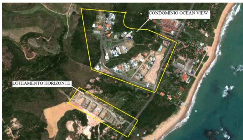
Fig. 105 - Condomínio Ocean View – Vista aérea
