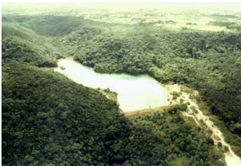
Ilustração 6 - Vista aérea da Barragem do Catolé.
