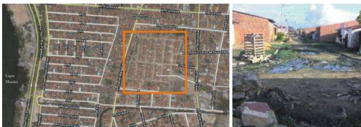
Figura 51. Conjunto Lenita Vilela: a) Localização - imagem aérea; b) Vista de uma das ruas.
