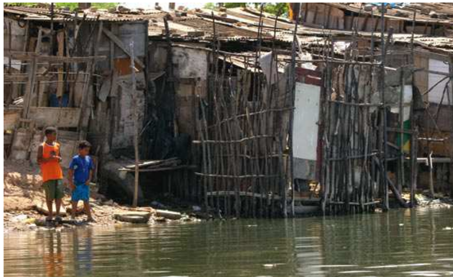
Figura 43. Exemplo das condições precárias e de risco à vida da população das Favelas do Dique-Estrada.
