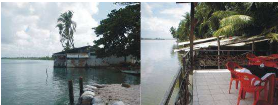
Figura 57. Construções sobre a lagoa Mundaú, bairro do Pontal da Barra
