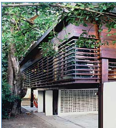
**Figura 9** – Exemplo de cobogó e painéis de madeira vazados.
