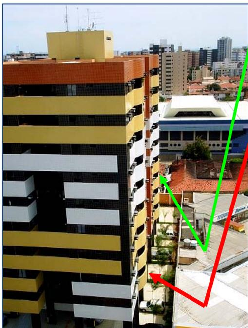
**Figura 38** – Esquema da insolação refletida pelo telhado do posto para os apartamentos do poente.
