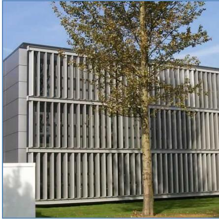
**Figura 5** – Protetores solares: brises verticais.
