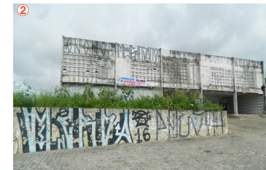
3 Edificação próximo ao Parque das Flores, Durval de Góes, 2018.
