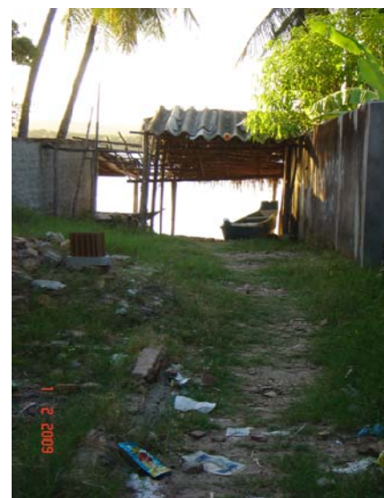
Figura 38- Falta infra-estrutura no bairro, do esgoto a céu aberto a acumulo de lixo. Fonte: Vanessa Gonçalves. Junho/09.
