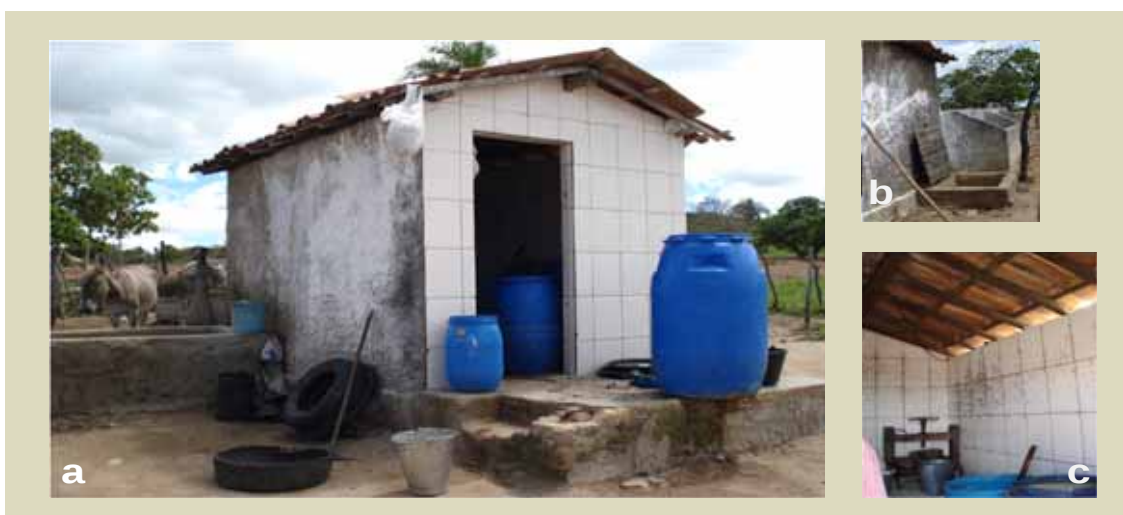
Figura 4.13 – Vista externa da Fabriqueta 2
