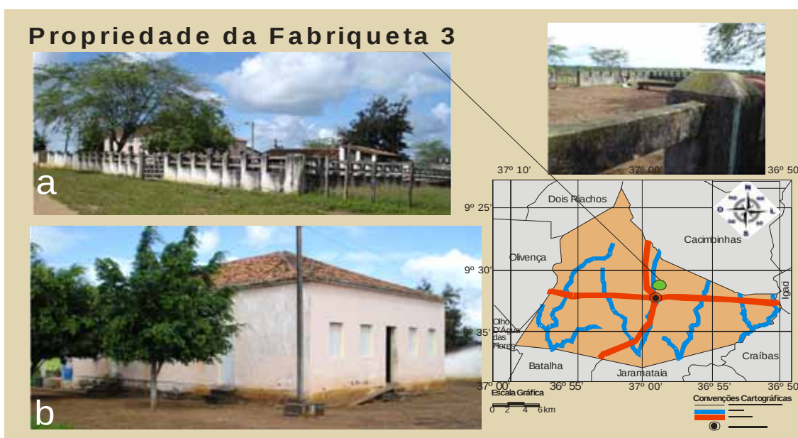
Figura 4.14 – Vista externa da Propriedade 3
