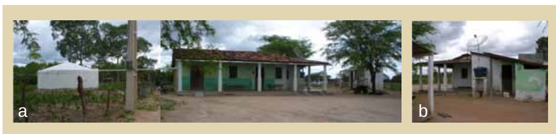
Figura 4.4 – Vista externa da propriedade da Fabriqueta 1
