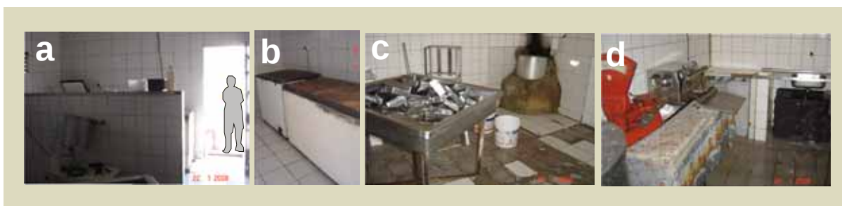
Figura 4.28 – Vista interna da fabriqueta 5
