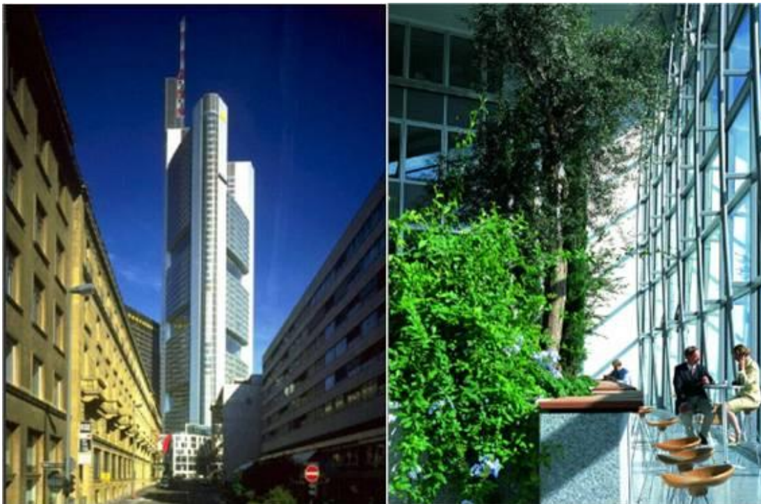
Figura 8: Commerzbank Headquarters, do arquiteto Norman Foster, em Frankfurt, Alemanha. Fonte: Foster and Partners. Disponível em: http://www.fosterandpartners.com .
