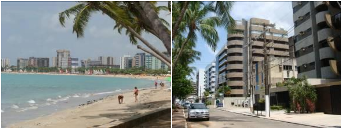
Figura 27: Verticalização na orla marítima de Maceió-AL, bairros de Ponta Verde e Jatiúca.
