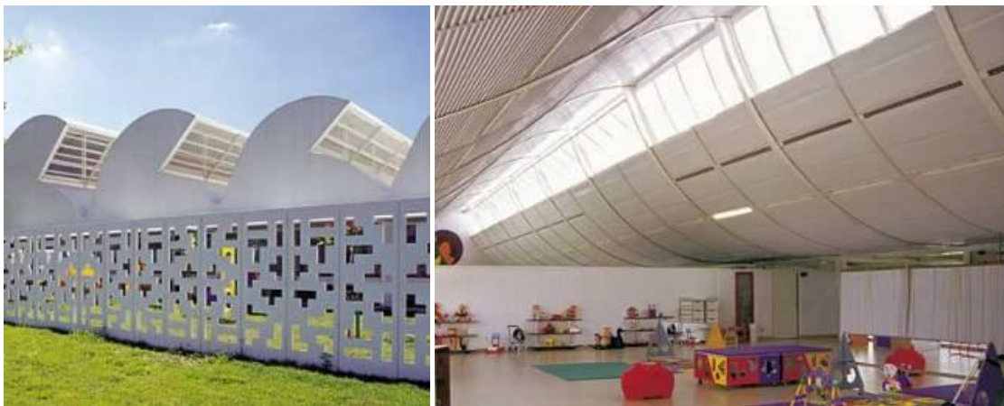
Figura 16: Utilização de sheds para aproveitamento da ventilação e iluminação naturais. Projeto do Centro de Reabilitação Infantil Sarah-Rio, no Rio de Janeiro, do arquiteto João Filgueiras Lima. Fonte: MOURA, 2002.
