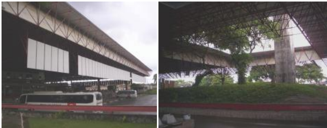
Figura 12: Terminal Rodoviário da cidade de Maceió-AL. Projeto Arquitetônico dos arquitetos Leonardo Bittencourt, Mário Aloísio Melo e Eduardo Assumpção. Fonte: CAVALCANTI, 2008.
