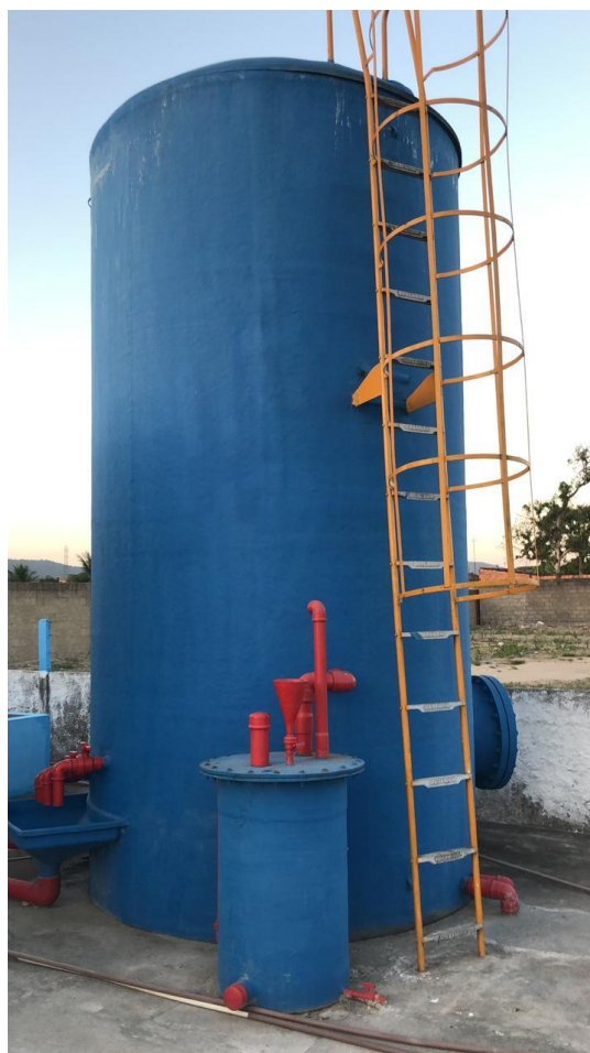
Figura 9: Reator UASB da ETE Isaura Toledo.
