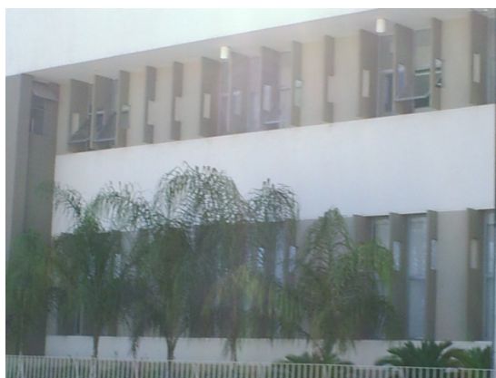
Ilustração 5 – Fotografia de fachada que possui protetor solar vertical fixo – Sede da Socôco, Maceió/AL.
