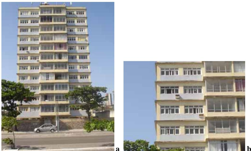
*a- Primeiro edifício de apartamentos de Maceió. Situado à beira mar, na sua composição volumétrica percebe-se o recurso estrutural adotado. Transparecendo a modulação vertical das colunas, vigas e as lajes marcando na fachada cada pavimento. Das janelas rasgadas deduz-se o ambiente interno de acordo com a metodologia do catálogo.*
