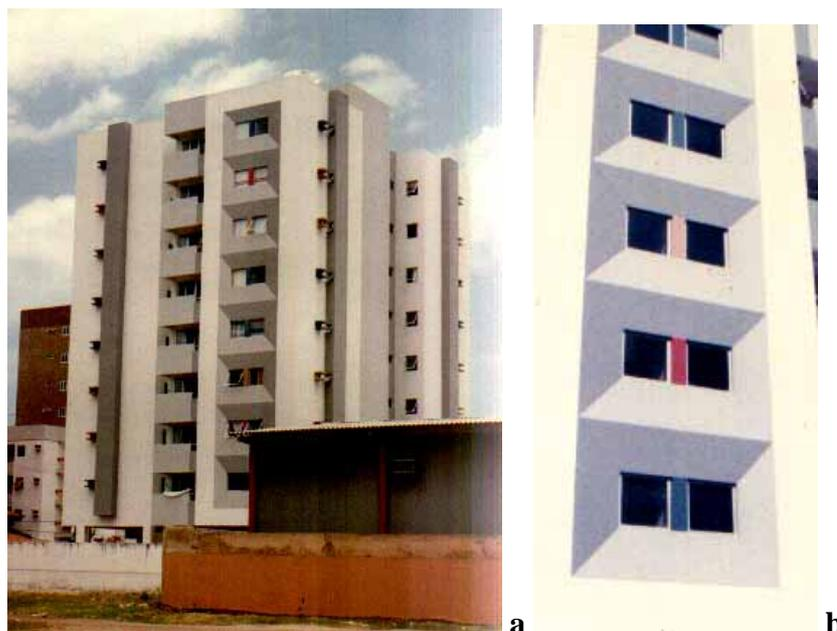
*a- Os cheios (paredes externas) são tratados com pintura texturizada, onde os diferentes tons de cinza conferem uma impressão de relevo na fachada, destacando as janelas maxim-ar de alumínio e vidro.
