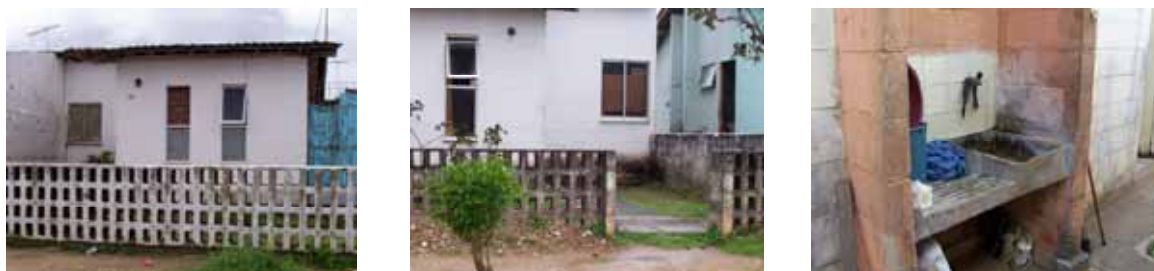
Fotografia 3.1 – Unidades com características originais – detalhe dos muros frontal e lateral e da lavanderia.
