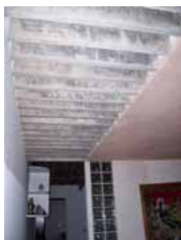
Fotografia 4.14 – Jardins de inverno construídos pelos moradores para melhores condições de iluminação e ventilação natural.
