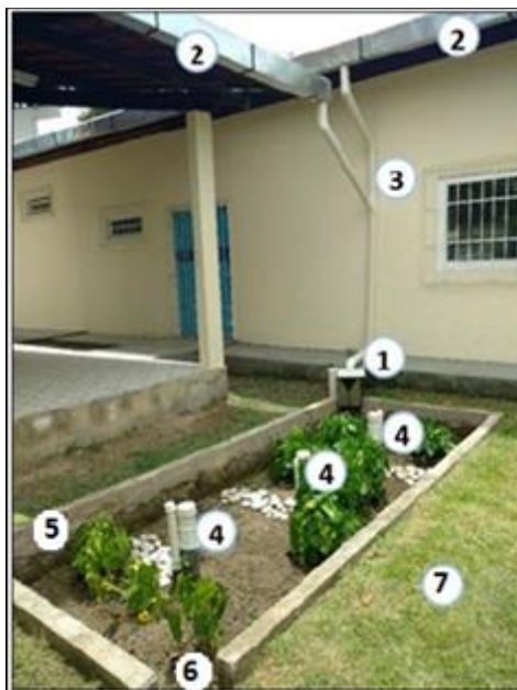
Figura 5 – Componentes do sistema de biorretenção
