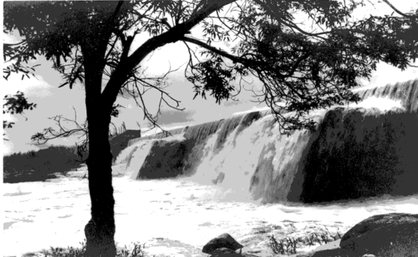
Figura 11 – Açude construído por Delmiro na Pedra.
