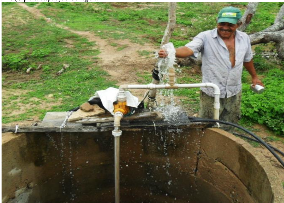
Figura 11: Poço para captação de água.
