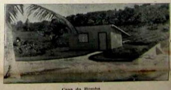
Casa da Bomba
