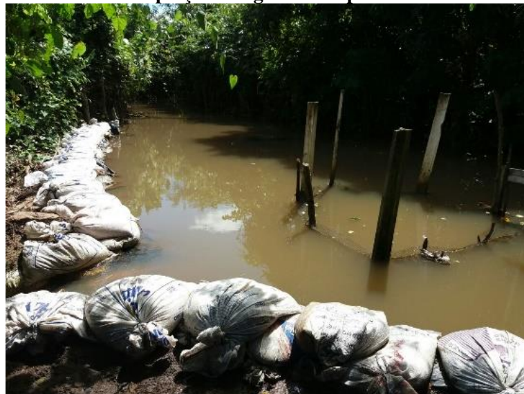
Figura 11 - Ponto de captação de água do rio para tratamento no SAAE.
