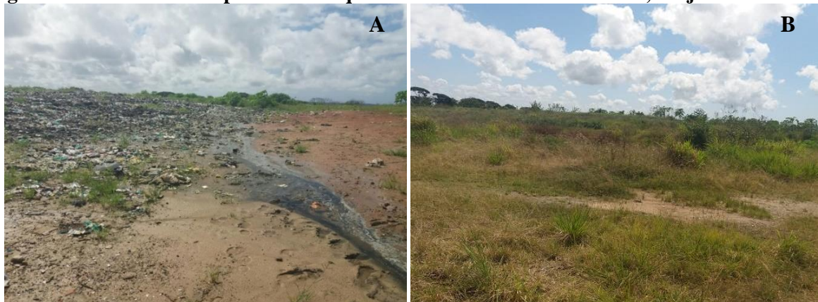
Figura 22 - Escoamento superficial do líquido lixiviado no lixão desativado, em janeiro de 2017.
