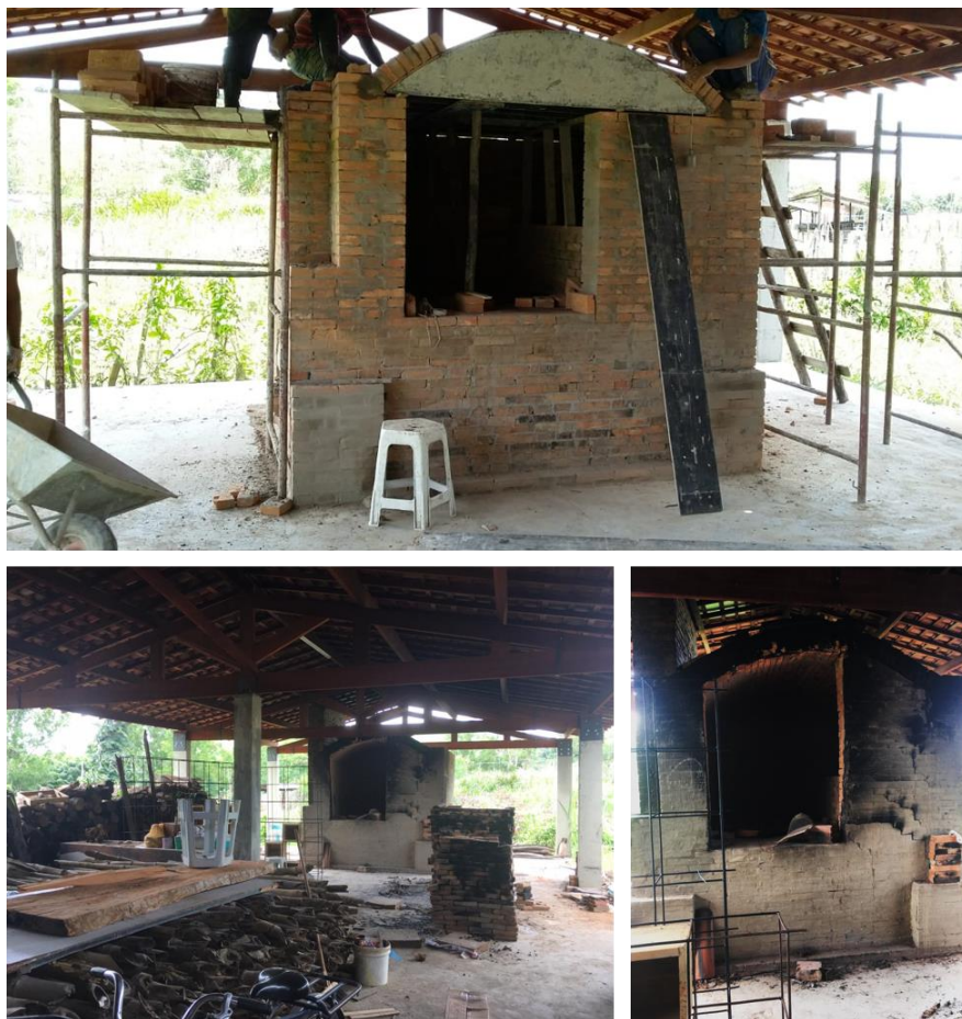
Fig. 4.11 – Novo forno, construído após o desabamento do galpão – A primeira foto é quando estava sendo construído; a segunda, já após sua utilização.
