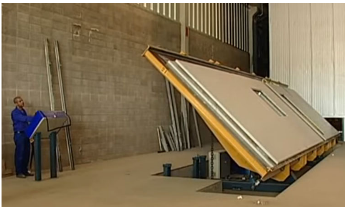
Figs. 24: Pré-fabricação de parede composta por dois painéis. Fonte https://www.youtube.com/watch?v=OybHpEYULTQ;
