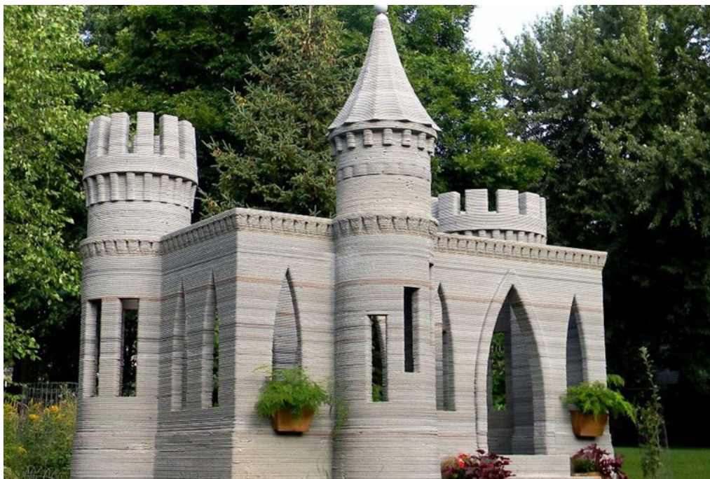
Fig. 162: Castelo em escala reduzida impresso em concreto.
