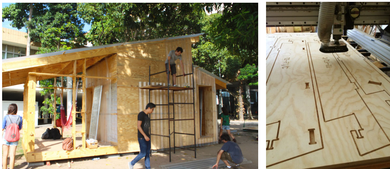
Figs. 32 e 33: A construção da casa opensource Wikihouse pelo LAMO3D – FAU UFRJ. Fonte: https://www.archdaily.com.br/br/773676/casa-revista-a-primeira-casa-fabricada-digitalmente-no-brasil ;
