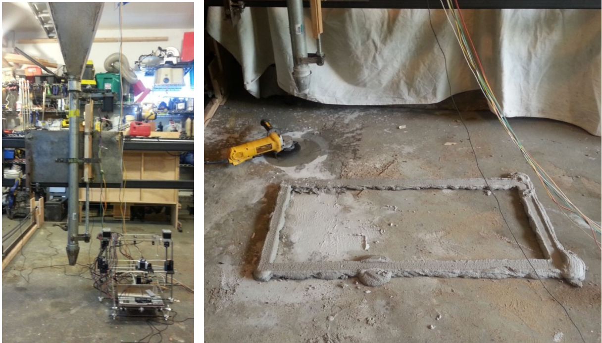
Fig. 166 e 167: primeira camada impressa em concreto.
