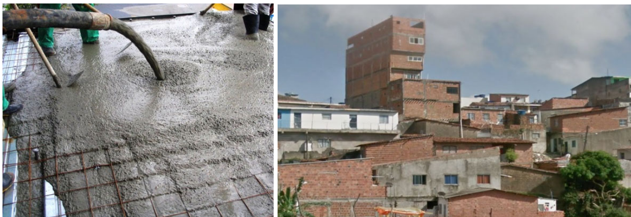
Figs. 25 e 26: O concreto armado, material de construção mais consumido no mundo, permanece no inconsciente coletivo como seguro e confiável, permitindo “sustentar” construções ousadas. Na imagem da direita, temos uma construção irregular em Maceió com sete pavimentos. Fonte: o autor
