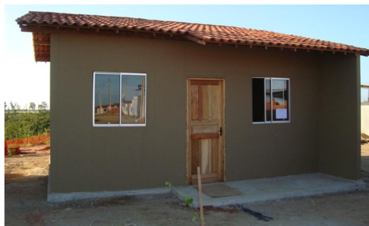
Figura 33: Protótipo analisado – conjunto habitacional em fase de construção.
