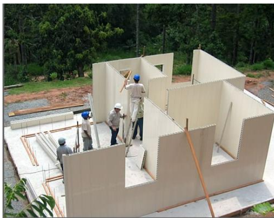
Figura 07: Montagem dos painéis de vedação em concreto de PVC.
