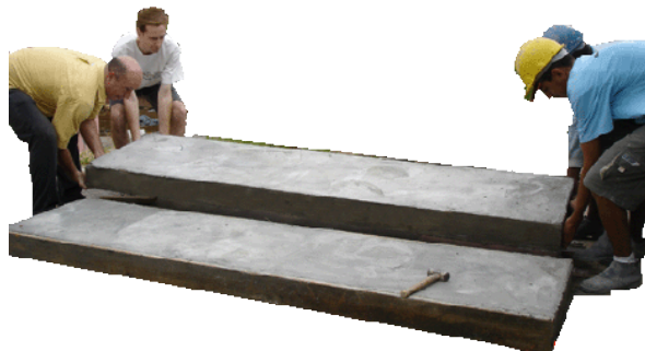
Figura 09: Concretagem e desmoldagem dos painéis.
