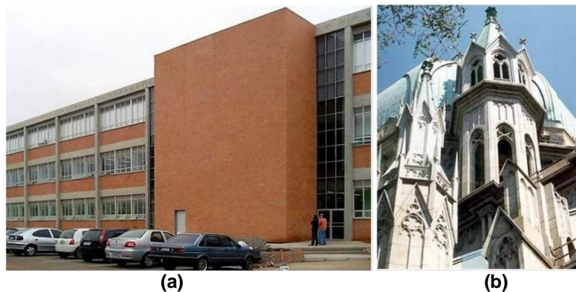
Figura 05: Fachadas reproduzidas com painéis GRC. (a) Faculdade de Odontologia de Ulbra – Canoas. (b) Novas torres da Catedral da Sé, São Paulo.
