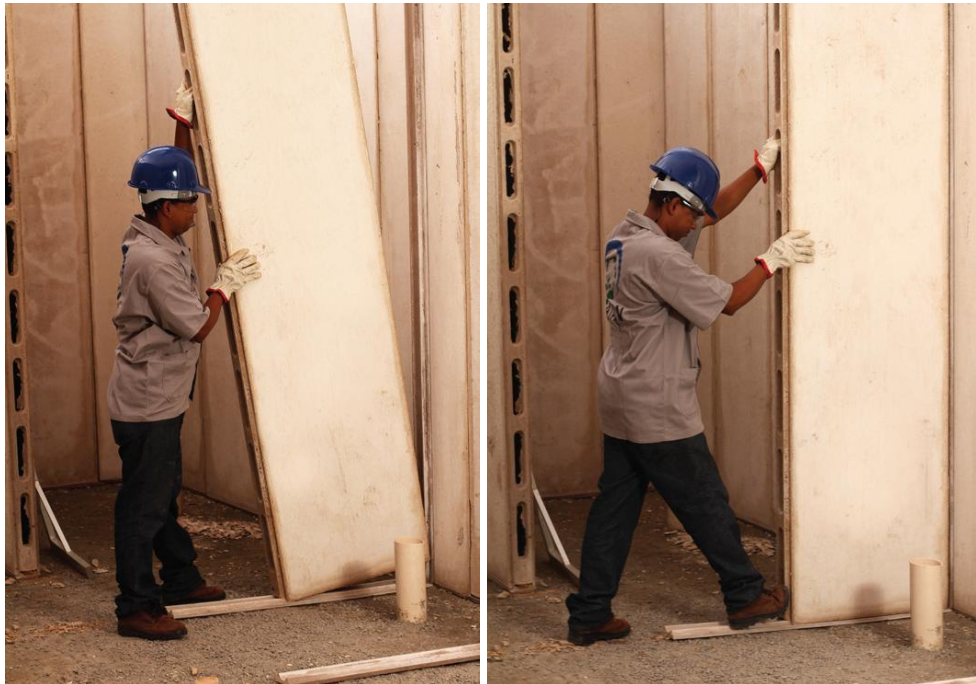
Figura 14: Montagem dos painéis.
