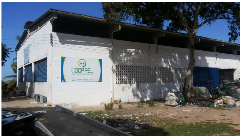
Figura 20: Galpão da COOPREL 2
