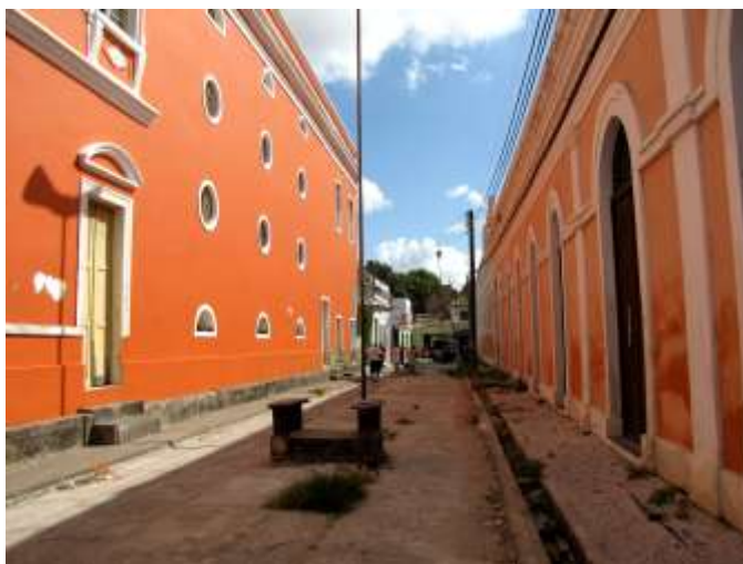
Figura 106: Rua Carvalho Sobrinho, entre o Mercado Público e o Teatro Sete de Setembro onde anteriormente às intervenções eram ocupadas pelas bancas da feira. Fonte: AUTORA, 2012.
