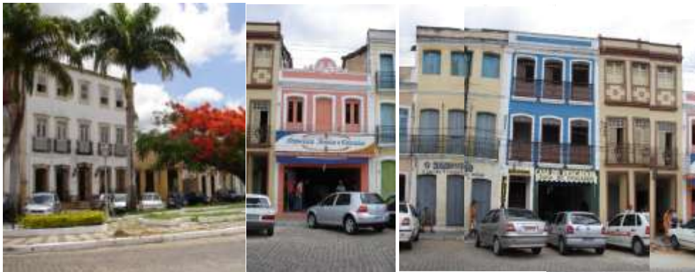
Figura 20, 21 e 22: A Praça 12 de Abril inicia a Rua do Comércio que se estende pela beira rio. Ainda consolida alguns exemplares de sobrados de dois e três pavimentos. Fonte: MACÊDO, 2005.
