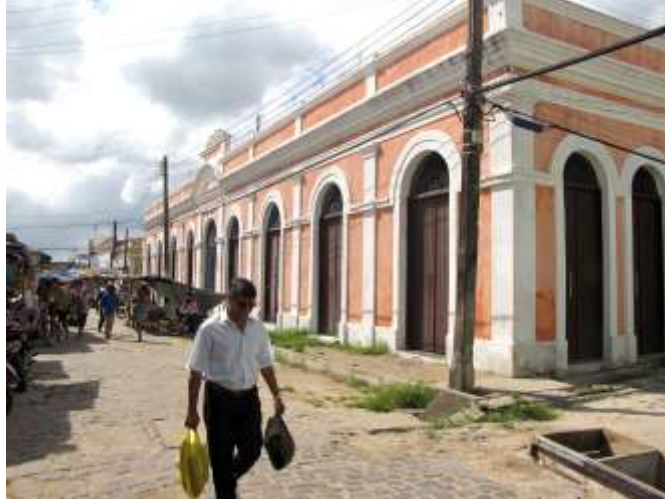
Figura 53: Fachada posterior do Mercado Público em foto atual. Após processo de restauração poucas bancas da feira voltaram ao local, em parte devido ao prédio não ter retomado suas atividades. Fonte: AUTORA, 2012.
