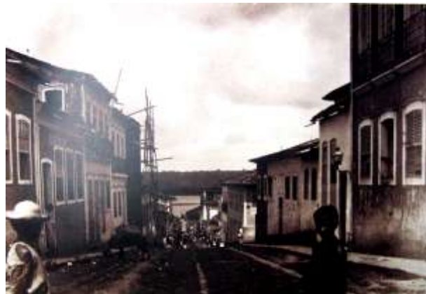
Figuras 36: Outro arruamento da cidade, também registrado por Adolpho Lindemann, com data de 1888, denota o aspecto de sujeira na rua. Fonte: LAGO, P; LAGO, B., 2008.
