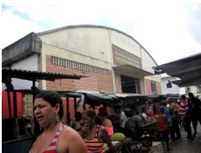
Figura 108: Galpão adaptado para abrigar os comerciantes de carnes que ficavam no Mercado Público, embora situado na Rua Sabino Romariz – um dos arruamentos da feira –, pelo seu deslocamento rompeu a logística com a farinha e demais produtos. Fonte: AUTORA, 2012.
