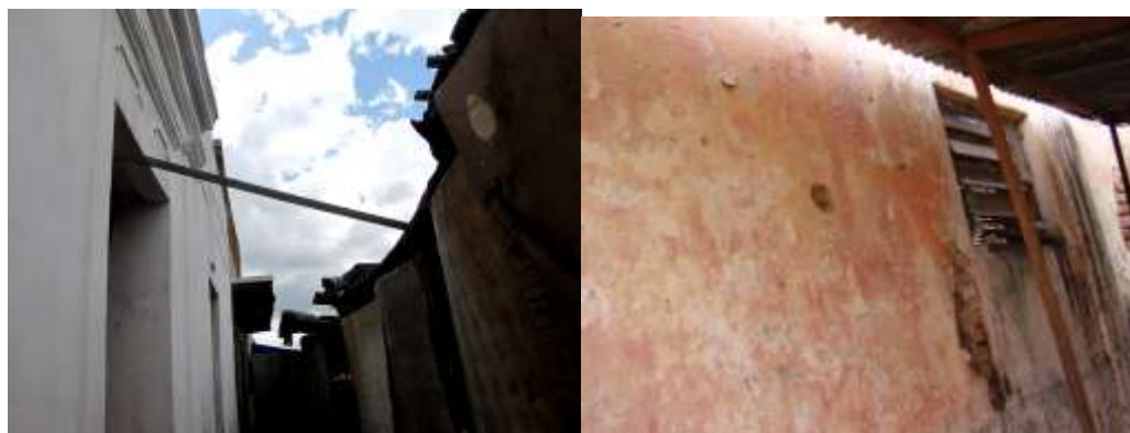
Figura 100 e 101: Detalhe do uso das edificações pelas bancas da feira como suporte de apoio. Fonte: AUTORA, 2012.
