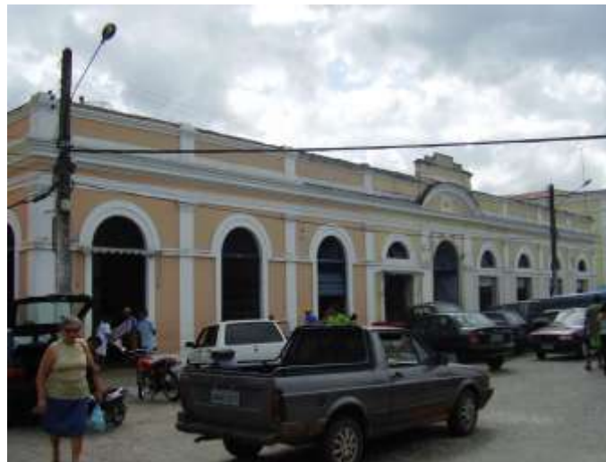
Figura 29: Imagem atual do Mercado Público que denota a conservação de suas características tipológicas originais. Fonte: AUTORA, 2007.
