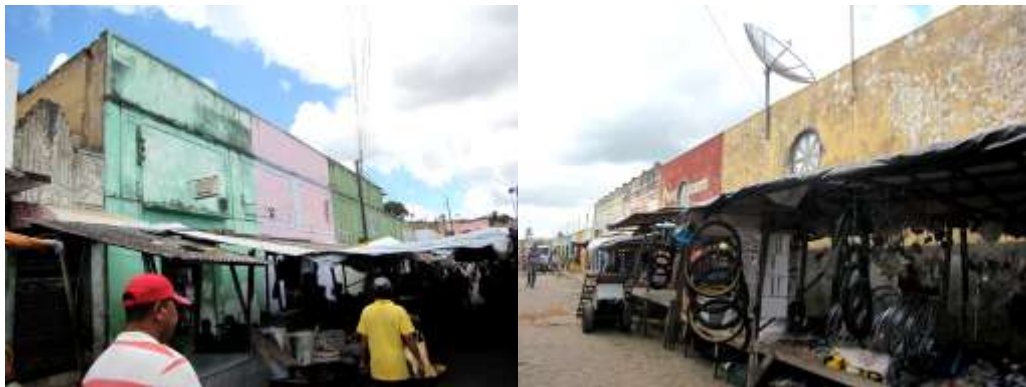
Figura 33 e 34: Edificações do entorno da Feira que mesmo com intervenções posteriores ainda denotam aspectos peculiares do período que foram construídas. Fonte: AUTORA, 2012.
