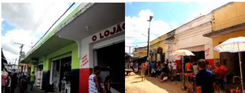
Figuras 96 e 97: Amostra da característica predominante da tipologia das edificações de pavimento térreo nos arruamentos em que a Feira Livre se estabelece. Fonte: AUTORA, 2012.
