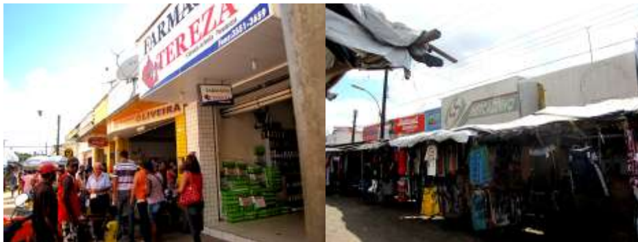
Figuras 94 e 95: Detalhe dos revestimentos cerâmicos nas alterações de fachadas e acréscimo de platibandas para comunicação visual dos estabelecimentos comerciais. Fonte: AUTORA, 2012.
