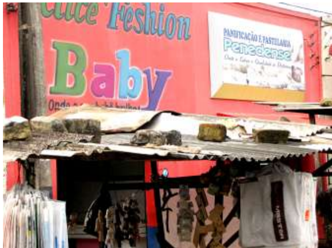
Figura 109: Precariedade da estrutura da cobertura de algumas bancas, que em alguns casos só possuem uma lona de cobertura. Fonte: AUTORA, 2012.
