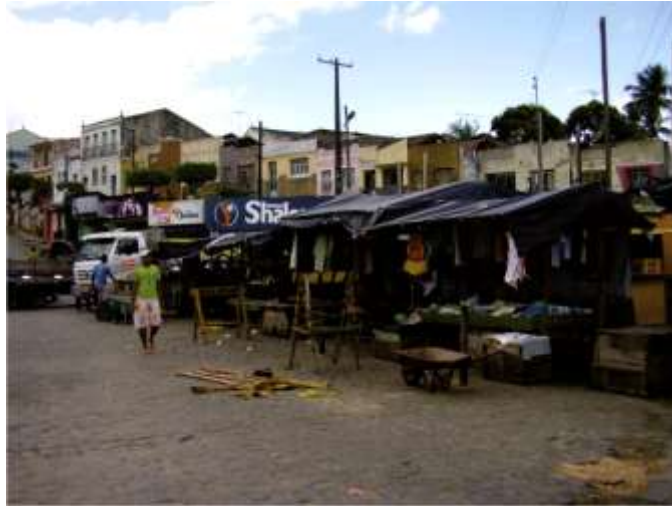
Figura 68: Mostra do acervo arquitetônico parcial de entorno da feira livre na Praça Costa e Silva, com visíveis descaracterizações. Fonte: AUTORA, 2007.
